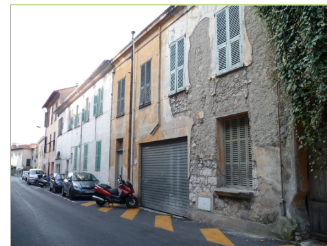
Rue des Soeurs Munet - Partie Nord
