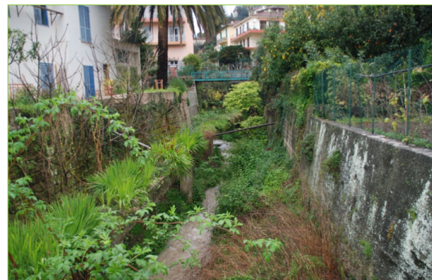
Le Fossan au niveau du chemin de Belle brise
