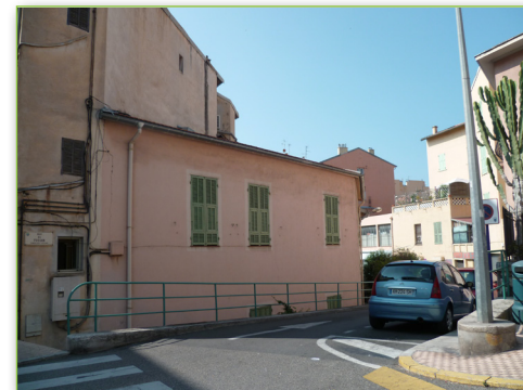
Rue du Fossan
